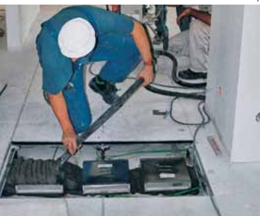
4 La "Protección contra incendios" es cada vez más importante. En la imagen se están colocando mamparos alrededor de conductos de distribución.
