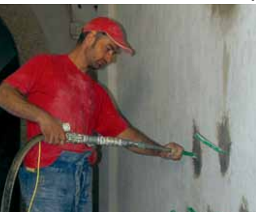
3 Inyección de mortero con la Sprayboy®.
