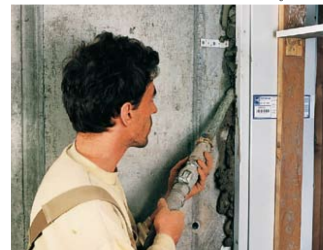
C'est la machine idéale pour des mini-chantiers, comme ici pour le remplissage d' huisseries ou pour la rénovation.
