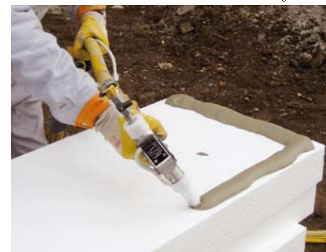
Vous pouvez utiliser la MP 22 sans problème pour des applications plus exigeantes, comme ici pour des systèmes d'isolation thermique extérieure.
