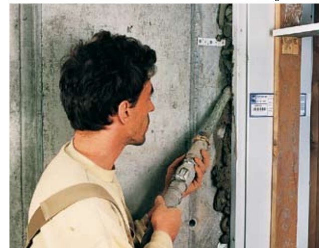
È la macchina ideale per piccoli interventi, come in questo caso di riempimento di intelaiature o per lavori di risanamento.
