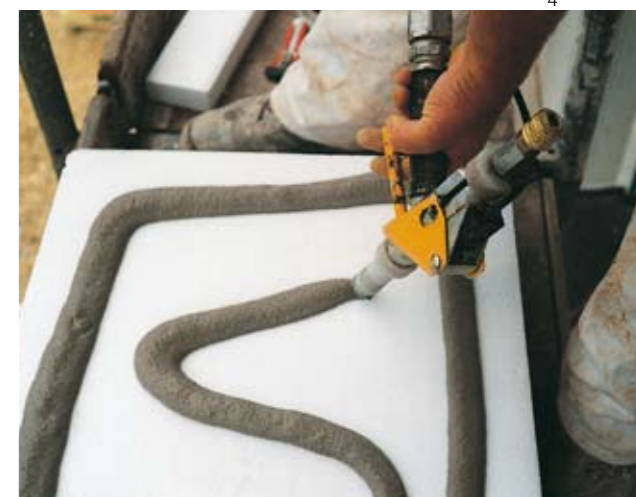
La MP 22 può essere utilizzata senza problemi per impieghi più sofisticati, come nel caso dei sistemi combinati di isolamento termico.
