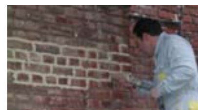
Jointolement de murs en klinker
