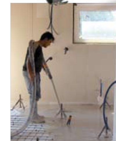
Chape autonivellante avec la S 5 EF
