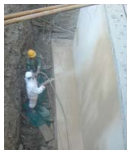
Revêtement de fondements en béton
