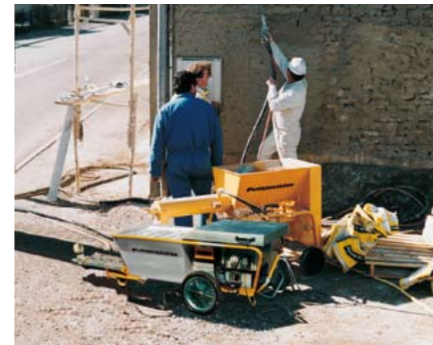
In combinazione con un miscelatore continuo (CM 528), la SP 5 diventa ancora più efficiente.
