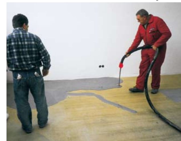
Ma con le pompe a coclea universali è possibile perfino l'applicazione di malta autolivellante (che in questo caso viene applicato con una S 5 EV TM all'interno di un capannone industriale).
