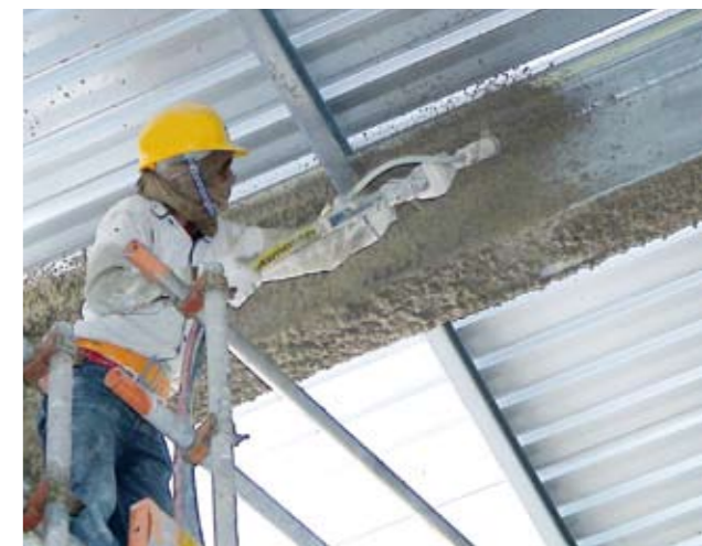
... ili za posebne primene, ovde je prikazano nanošenje protipožarnih nanosa.
