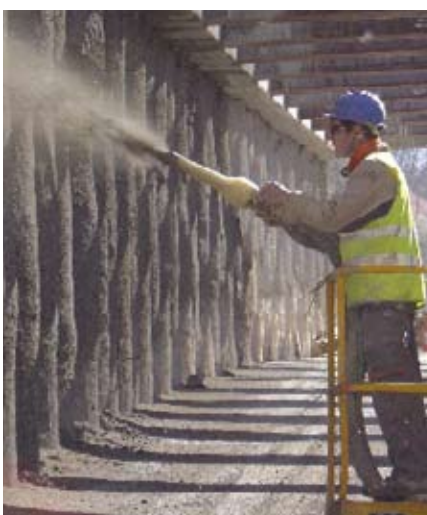
Le pompe per il calcestruzzo fine, come la P 715, vengono annoverate tra i sistemi più poliedrici. Possono essere utilizzate per l'applicazione dello spritz beton.
