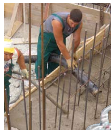
... oppure per pompare il calcestruzzo fine fino ad una granulometria di 16 mm. Grazie all'anello automatico a tenuta ermetica questa macchina può anche essere utilizzata per massetti autolivellanti molto fluidi (figura a destra).
