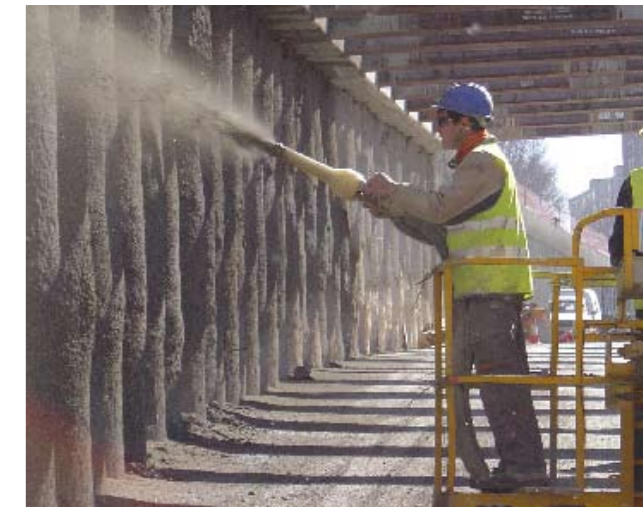
Pompy do betonu, takie jak P 715, zaliczane są do systemów wszechstronnych. Można używać jej do natryskiwania betonu, ...
