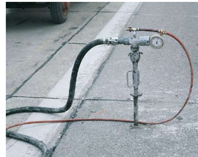
Hier werden Fahrbahnplatten mit einer Zement-Suspension mit der P 13 unterpresst.
