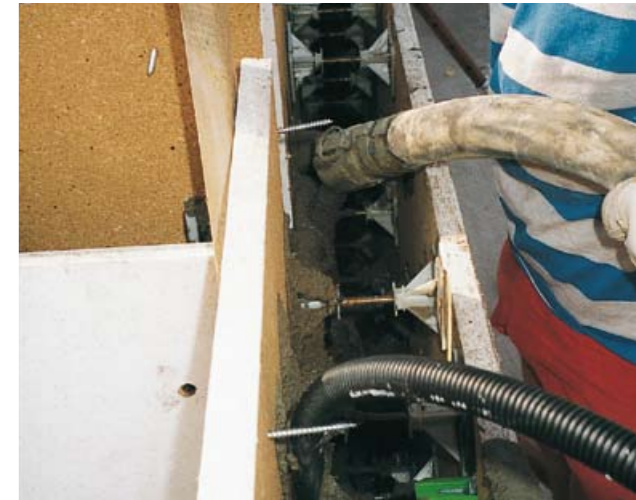
Neben Standard-Aufgaben wie Grund- oder Spritzputz eignet sich die P 13 auch hervorragend für Einsätze, wo große Mengen gefördert werden müssen, wie z. B. zum Verfüllen von Schalungssteinen.
