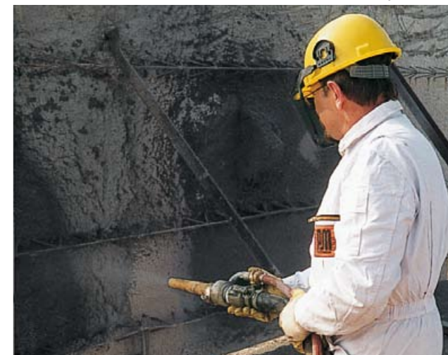
Größerer Spritzbeton (hier 8 mm) kann nur mit einer Kolbenpumpe wie der P 13 verarbeitet werden.
