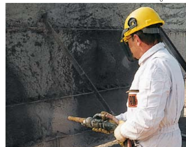
La malta spruzzata con granulometria grossa (qui 8 mm) può essere lavorata solo con una pompa a pistoni come la P 13.
