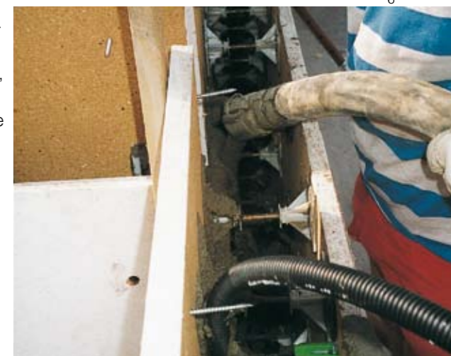
Oltre agli utilizzi standard, come l'intonaco di fondo o l'intonaco a spruzzo, la P 13 è ideale anche in impieghi dove è richiesto il convogliamento di quantità elevate, come ad esempio nel riempimento di casseforme.
