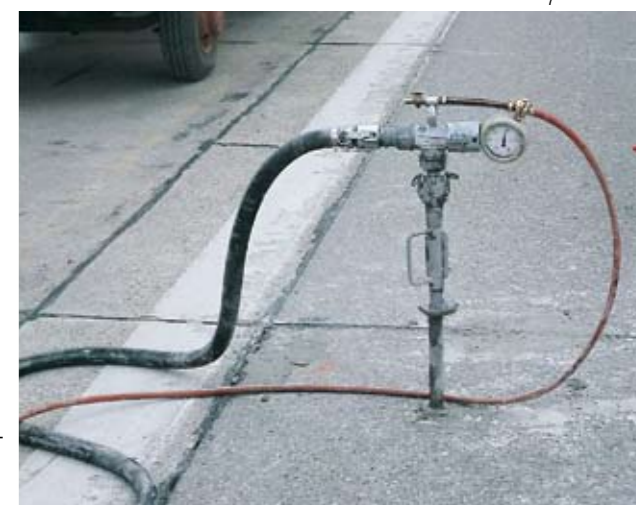
In questo caso, con la P 13 viene iniettata in pressione una sospensione in cemento nella piattaforma stradale.
