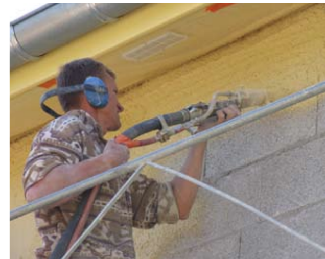
Le pompe a coclea SP 11 vengono utilizzate, all'esterno come all'interno, per realizzare tutte le miscele da cantiere e lavorare la malta premiscelata fino a 6 mm.
