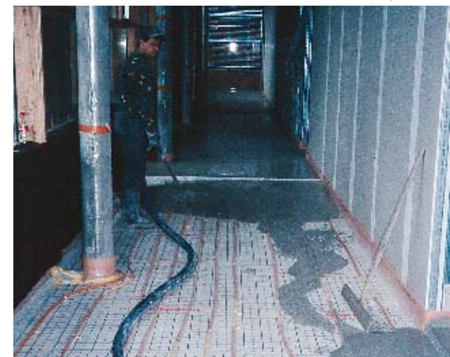
Con le corrispondenti parti della coclea sarà possibile persino pompare senza alcun problema ed in modo economico addirittura il materiale fluido.
