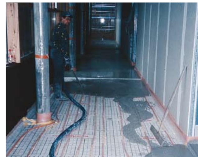
Met een aangepaste uitrusting kan ook vloeibare chape gemakkelijk en economisch worden verpompt.
