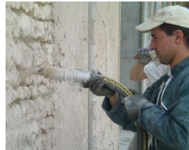
SP 11 wormpompen kunnen zowel binnen als buiten worden gebruikt voor alle werfgemaakte en droog voormengde mortels tot 6 mm korrelgrootte.
