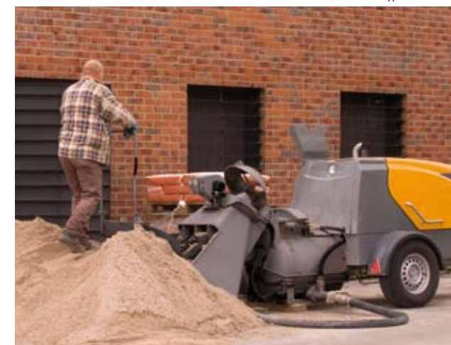
De nieuwe Mixokret in de uitvoering met vuller en schraper.
