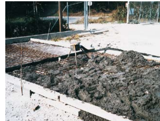
Zelfs beton tot 20 mm korrelgrootte pompt hij zonder problemen over grote afstanden.
