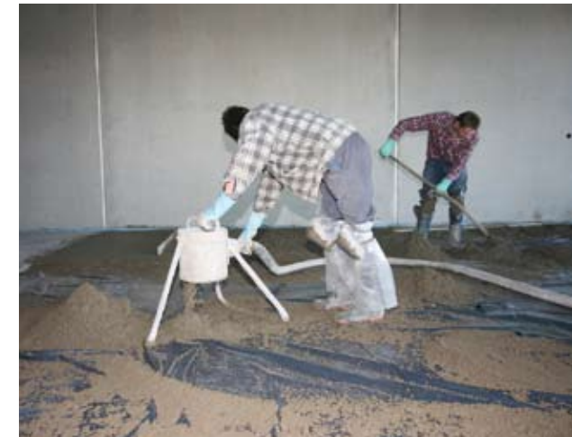
De Mixokret verpompt de meest verschillende materialen. Vloermortel + zand tot 8mm korrelgrootte, ...
