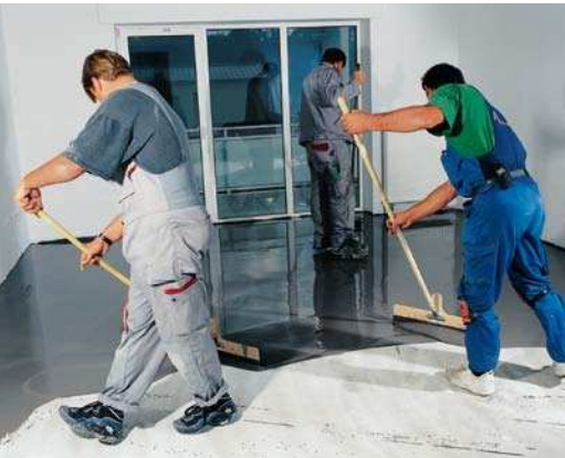
Fließspachtel ist eine selbstverlaufende Bodenausgleichsmasse, die zum Ausgleich des Untergrundes eingesetzt wird.
