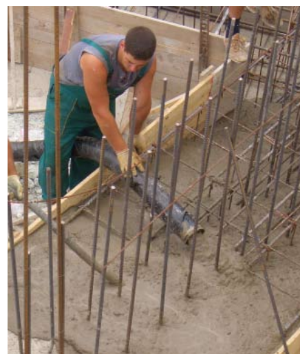
P 718 doprema beton do veličine zrna od 32 mm, između ostaloga.
