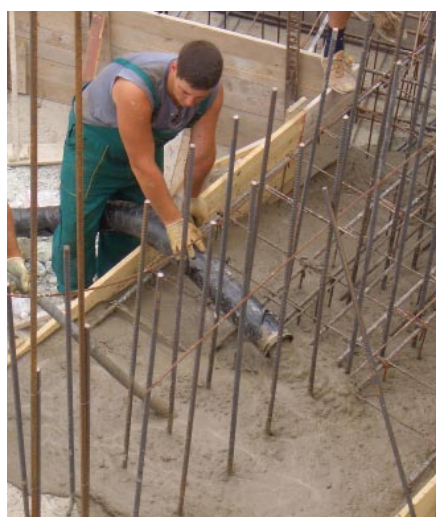
Наравне с другими материалами Р 718 прокачивает бетон с фракцией до 32 мм.
