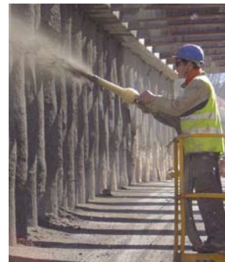
Feinbetonpumpen, wie die P 715, zählen zu den vielseitigsten Systemen. Sie können sie für Spritzbeton einsetzen, ...
