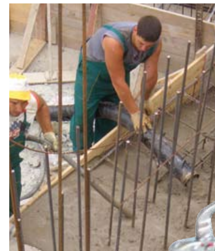
... oder für das Pumpen von Feinbeton bis 16 mm. Durch den selbstabdichtenden Automatikring können Sie sie sogar für Fließestrich einsetzen (rechtes Bild).
